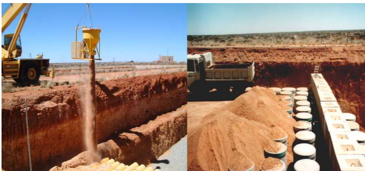
Figuur 6: Terugvulling van wegdoeningslote wat gevul is met afvalpakkette
